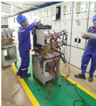
Gambar 2. Inspeksi dan Pengujian VCB
